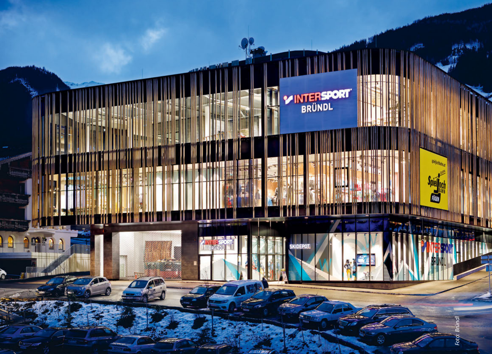
Außenfassade des neuen Intersport Bründl in Fügen.
